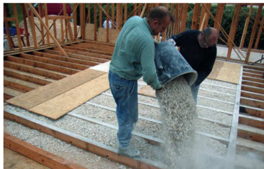
▲ Isolation en vrac par déversement
